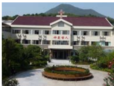
杭州市基督教敬老院第一期院舍
