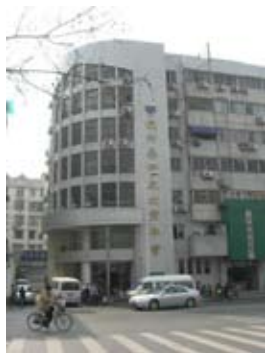
现杭州基督教女青年会 大楼
