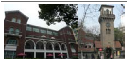
青年会大楼和钟楼现状
